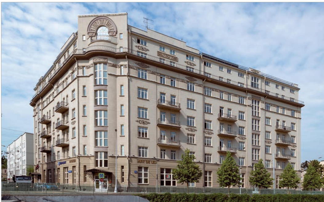
Офисное здание на Покровском бульваре. Источник: ГлавУпДК при МИД России
