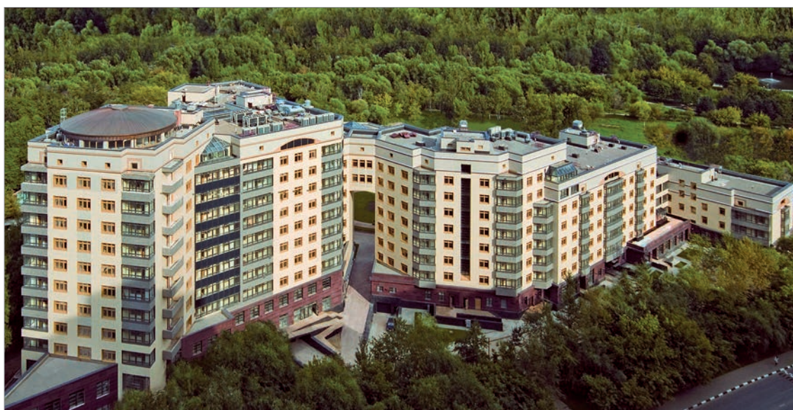
Многофункциональный комплекс «Пять прудов», ул. Новаторов
