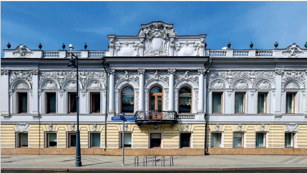
Обособняк генерала А.П.Ермолова - г. Москва, ул. Пречистенка, д. 20
