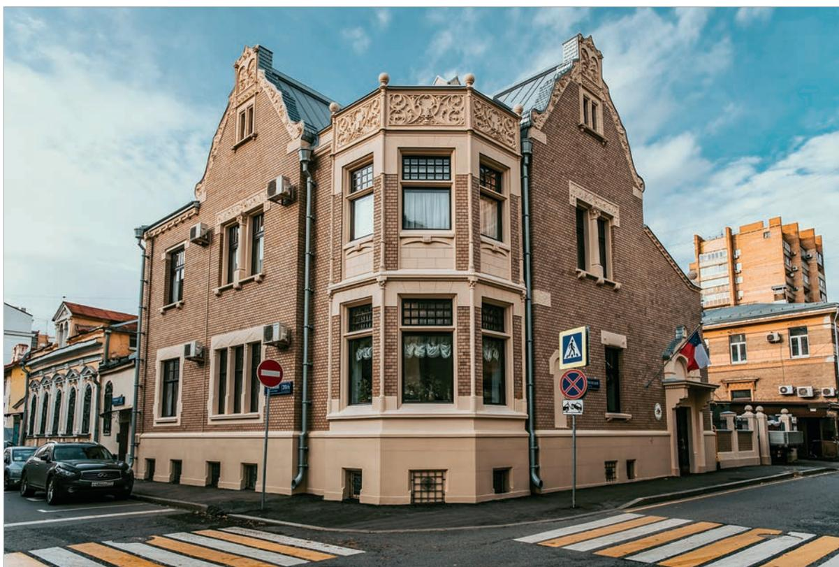
ны оригинальная водосточная система восьмигранных труб и водоприемных воронок, кованное ограждение балкона, металлическое покрытие «лемехом» над фронтонами восточного и южного фасадов здания.
