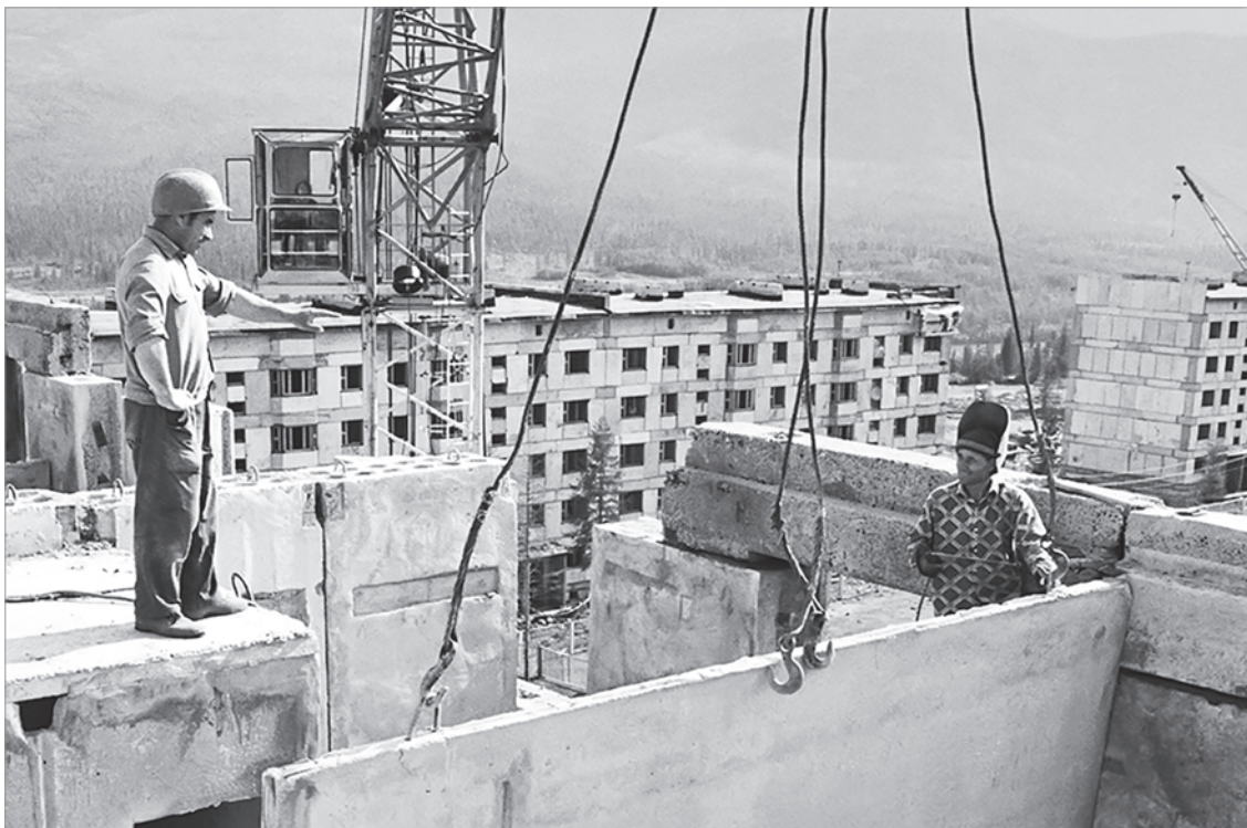
Строительные работы по возведению хрущевок. Источник: РБК
